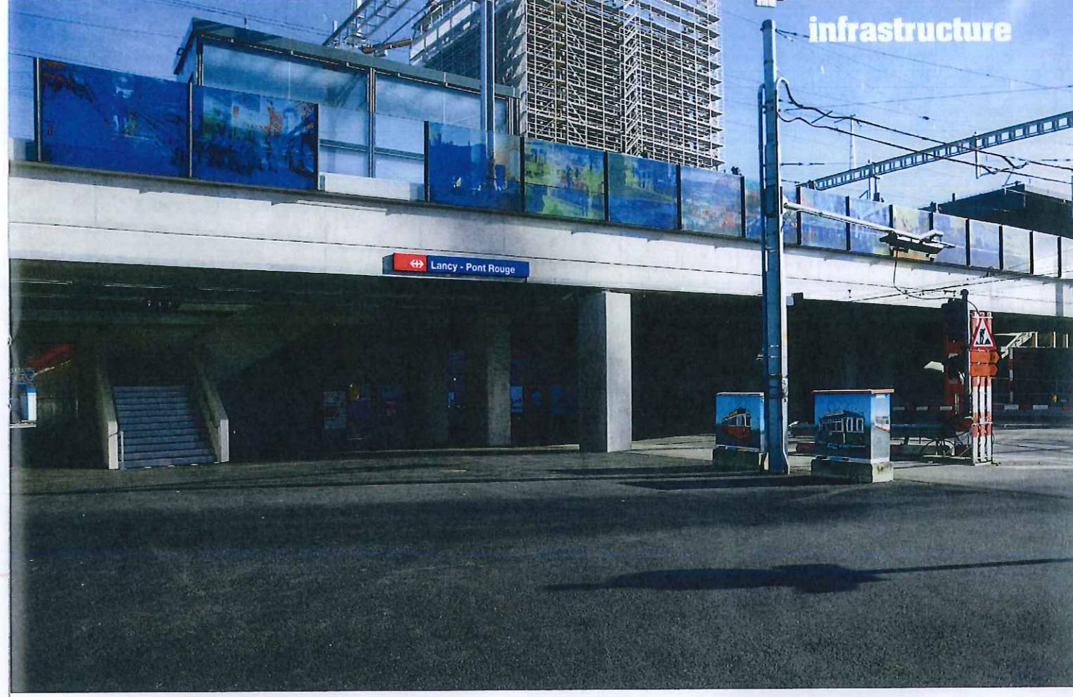
Construite au-dessus de la route du Grand-Lancy, le nouveau tronçon a nécessité de couler le béton sur place pour le passage sud. Une opération complexe, surtout dans l'optique de perturber le moins possible la circulation ferroviaire.
