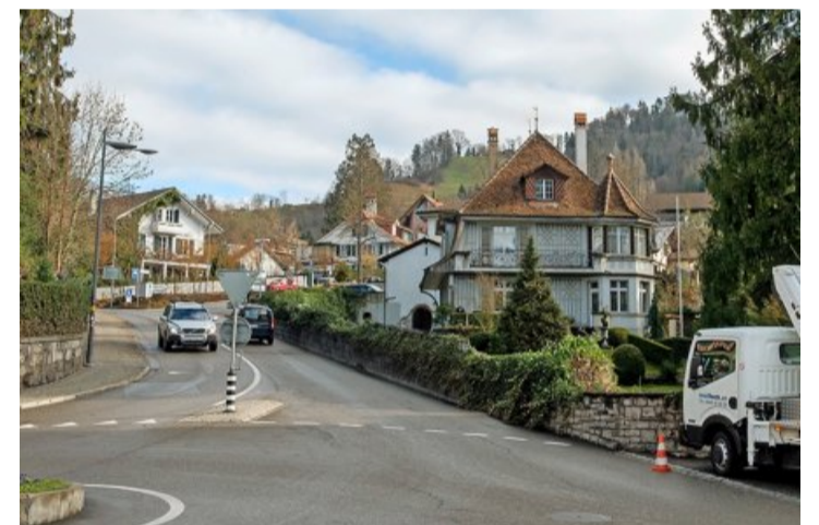
... gestern nun ist das viele Grün verschwunden. Der Kanton wird ab April bergwärts einen Radstreifen und ein Trottoir realisieren.
