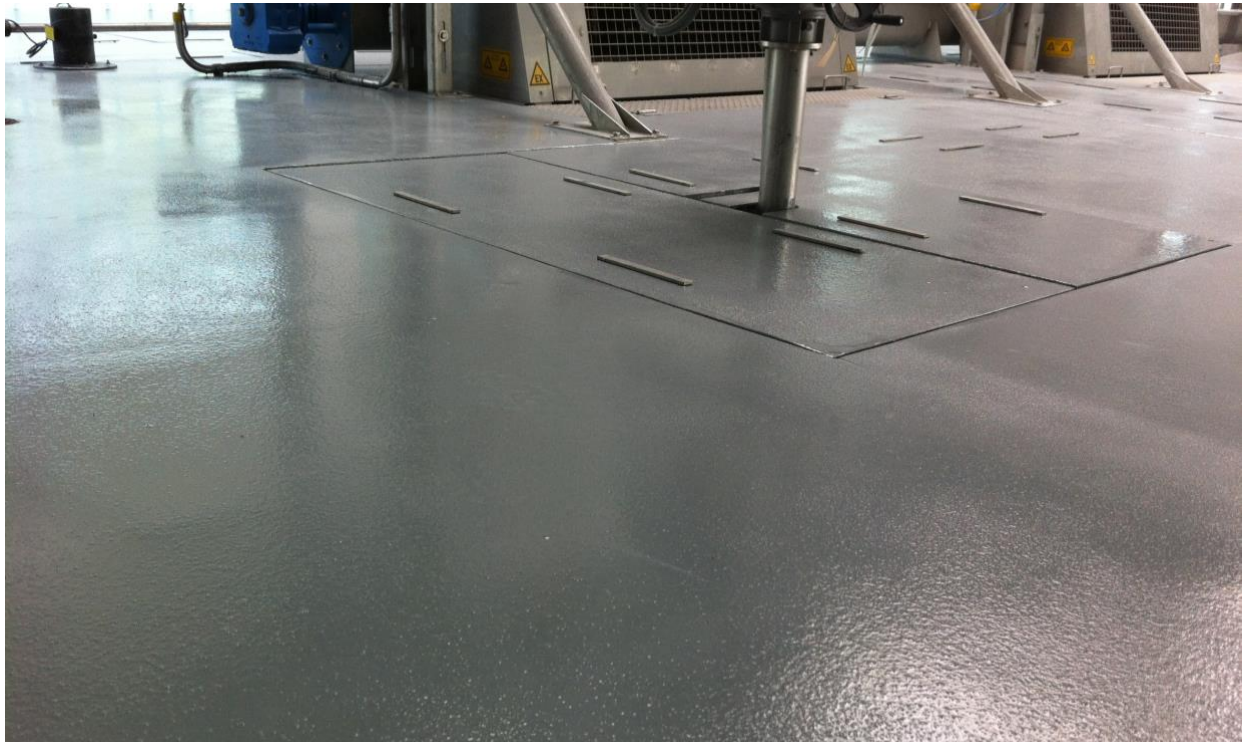
Abwasserreinigungsanlage ARA Neubrücke, Bern
