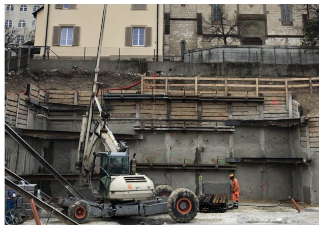
Binningen – Florastrasse 62 Stück Injektionsrammpfähle bis 12 Meter
