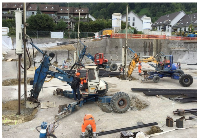
Stallikon – Neubau MFH Husmatt 34 Stück Rühlwandständer HEB220 gerammt
