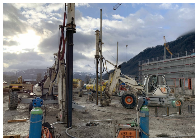
Bilten – Läderach 230 Stück Injektionsrammpfähle HEB100 / 120 / 160 / 180
