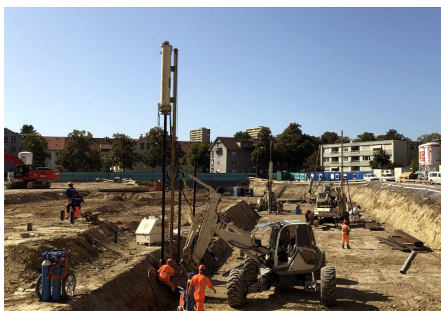
Bern – Hueberstrasse 270 Stück Injektionsrammpfähle HEA 100 / HEB 120
