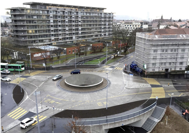
Bern - Kreiselkunstwerk LUWA Trichter aus Spritzbeton ohne Schalung
