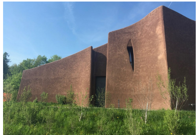
Muttenz – TWA Fassade mit eingefärbtem Spritzbeton
