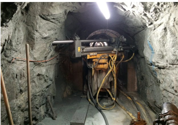
Emmoosson — Staumauer Fels- und Kontaktinjektion
