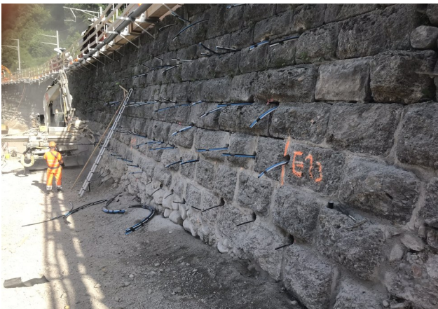
Wald-Rüti ZH - Linie 754 Stützmauer Injektionen in Natursteinmauer
