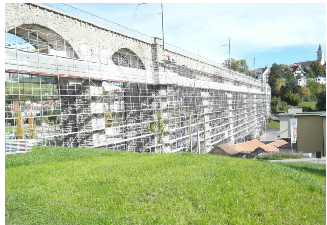
Herisau — Viadukt SBB Injektionen in Natursteinmauer
