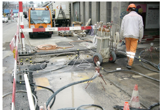
Basel — St. Johann Baugrundverfestigung mit Ventilrohren
