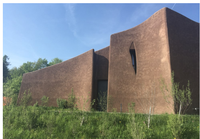
Muttenz - TWA obere Hard 2017 Fassade mit eingefärbtem Spritzbeton
