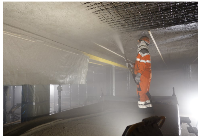
Uster—Sanierung Werkhof Betoninstandsetzung mit Spritzbeton
