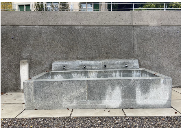
Ennetbaden—Heisse Brunnen Instands. Stützmauer mit Oberflächengestaltung
