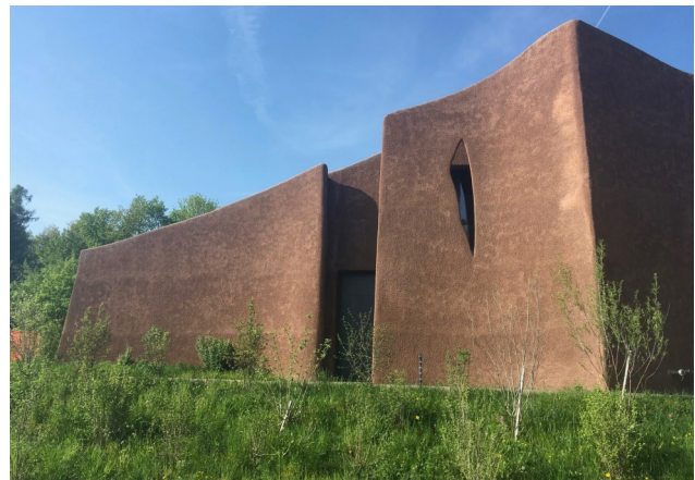
Muttenz – TWA Fassade mit eingefärbtem Spritzbeton
