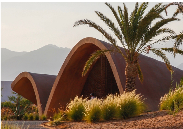
Jordanien – Golfanlage Konstruktion aus Spritzbeton ohne Schalung
