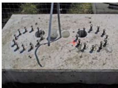
Autoroute A1/A3, Sargans: ancrages posés
