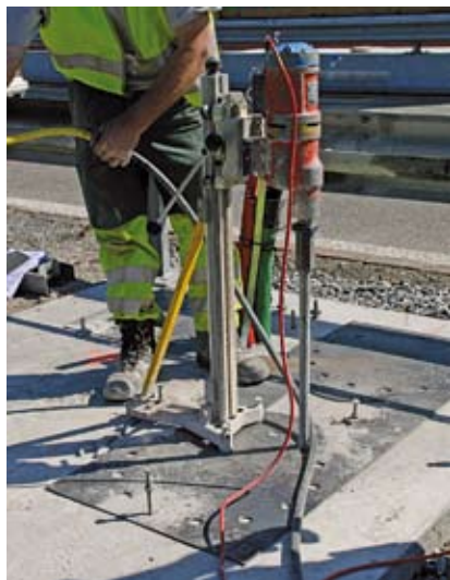
Autoroute A1/A3, Sargans: forage précis dans fondations en béton
