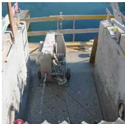
Wehranlage Kraftwerk Mühleberg, Seilsägen
