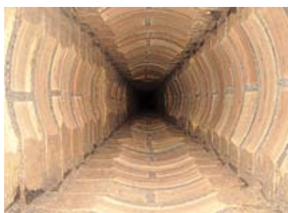
Crypto AG, Kaminausbohrung
