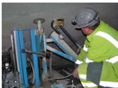
Tunnel d'Aescher, renforcement de la dalle intermédiaire
