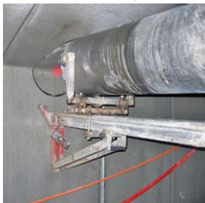
Construction du tunnel de l'Uetliberg – canal de conduites
