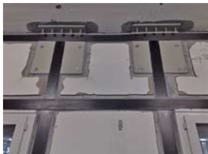
Deckenverstärkung mit CFK-Lamellen
