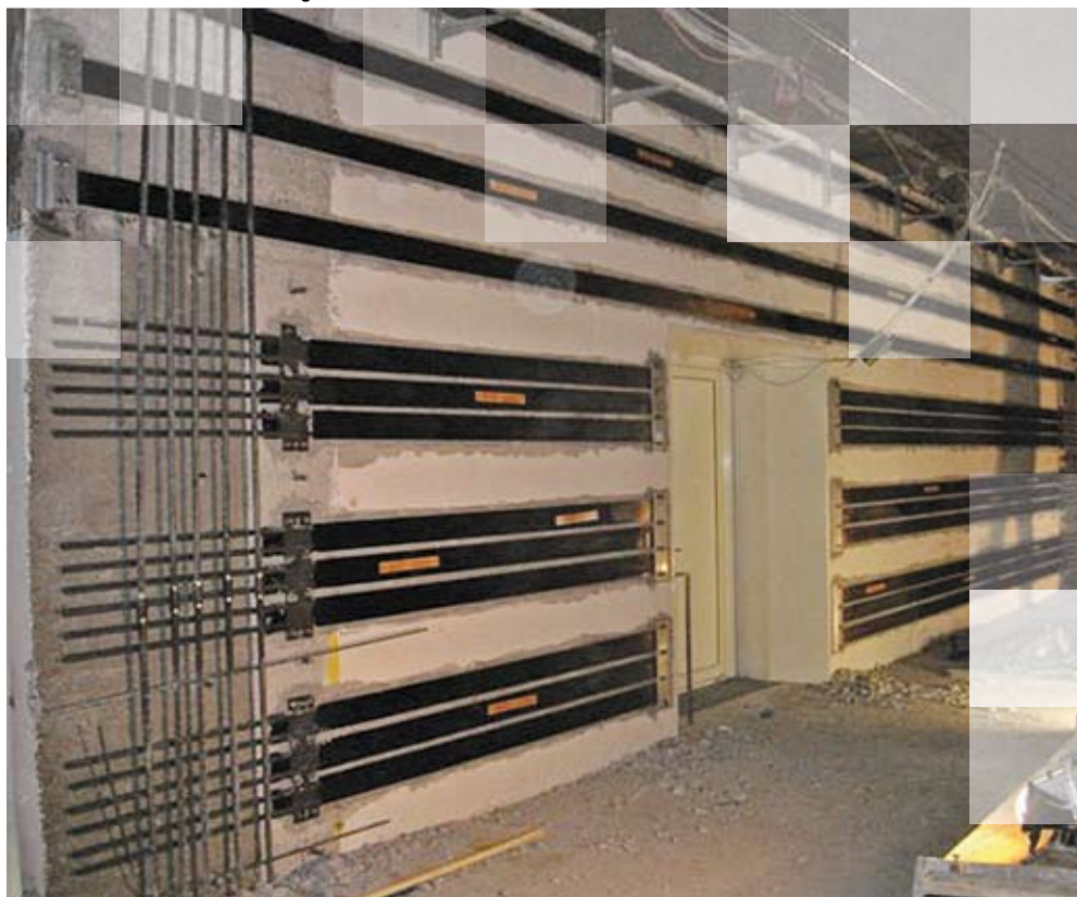
CFK-Lamellen mit Endverankerungen
