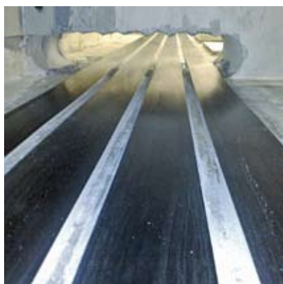
Wandverstärkung mit CFK-Lamellen über zwei Etagen
