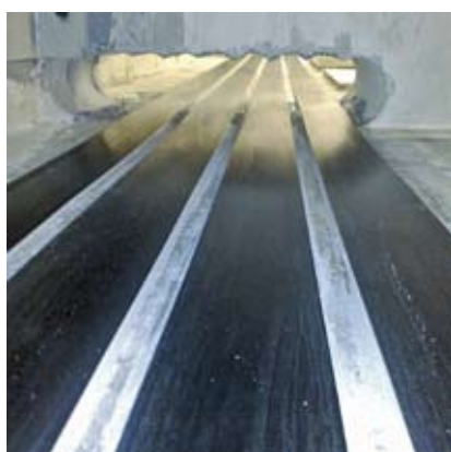
Renforcement d'un mur en béton sur deux étages avec des lamelles en CFC
