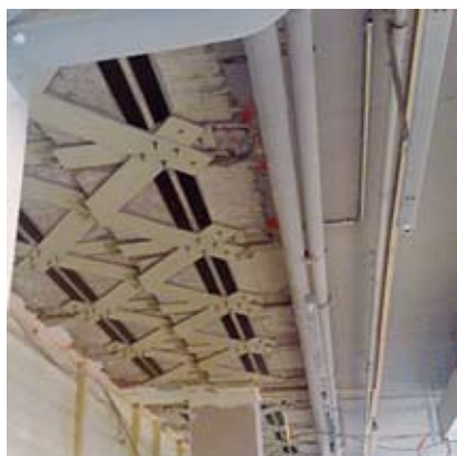
Renforcement combiné avec lamelles en CFC et en acier
