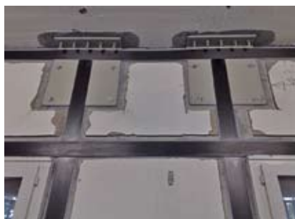
Renforcement d'une dalle avec lamelles CFC
