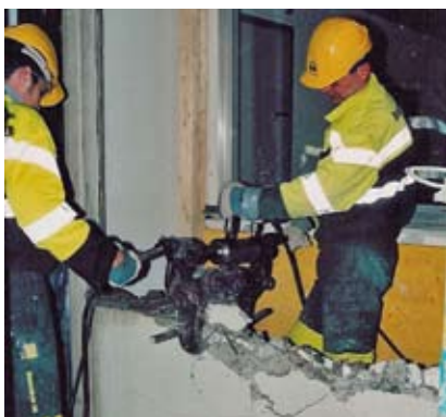
Knacken mit Handzange in bewohntem Gebäude
