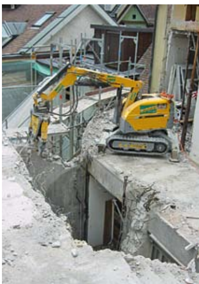
St. Gallen, Multergasse 1-3: Zangenabbruch mit Brokk 150
