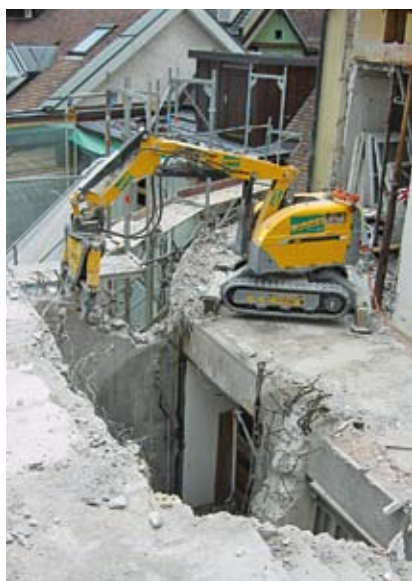
St. Gall, Multergasse 1-3: démolition à la pince hydraulique sur un robot du type Brokk 150
