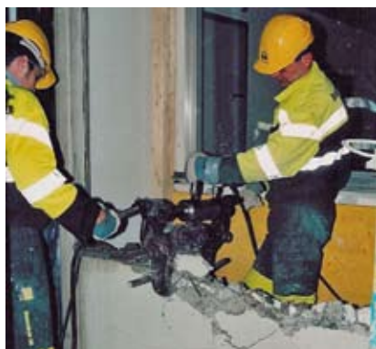
Démolition avec pince à main dans un immeuble habité
