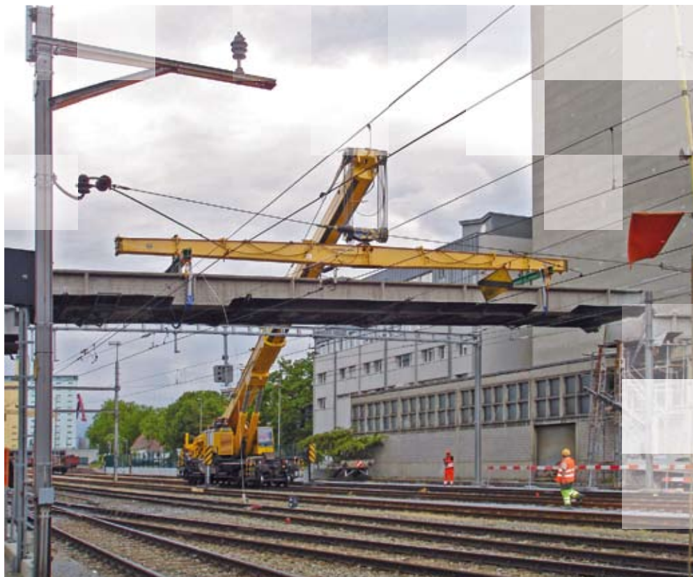
Basel: Schienenkran
