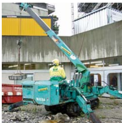
Thoune: démolitions de dalles de balcons et extraction avec engin de levage sur chenilles du type «Maeda»
