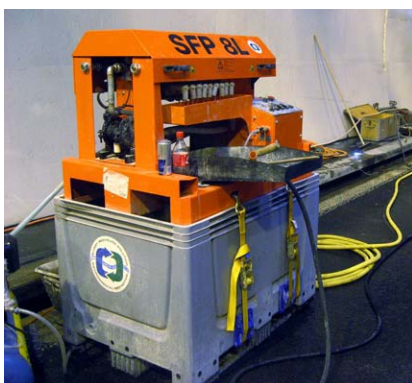
Einsatz der Schlammpresse im Gubristunnel
