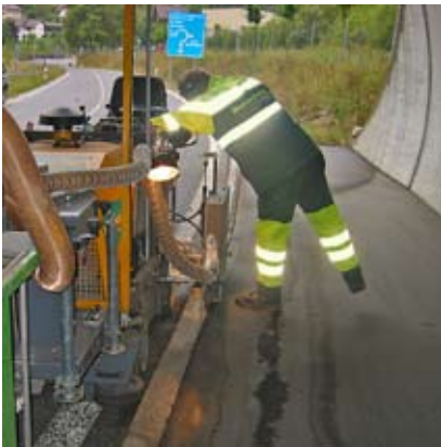
Tunnel Biel-La Reuchenette: Fugenschnitte
