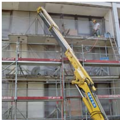
Trieschweg à Buchs: sciage de dalles de balcons
