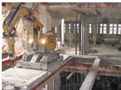
St. Gallen: Umbau Multergasse 1-3
