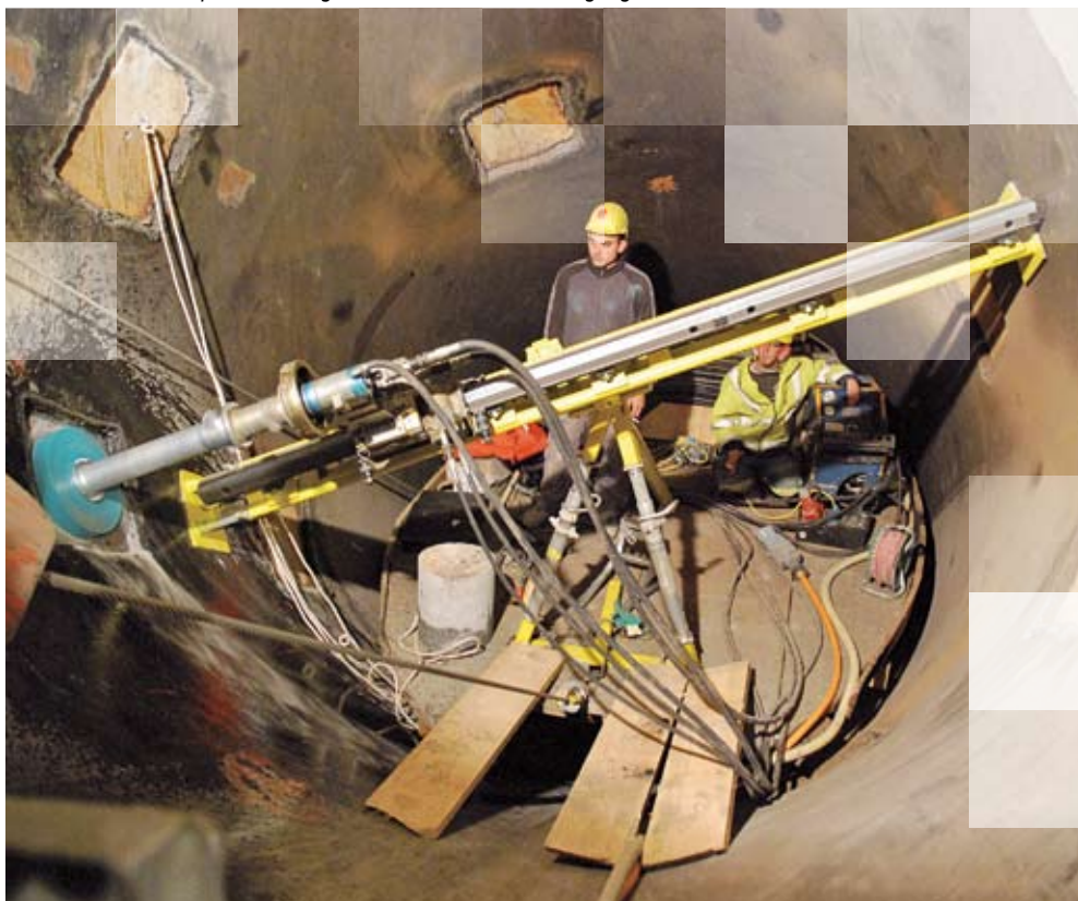
Druckstollen Wallis: Spezialbohrungen unter erschwerten Bedingungen
