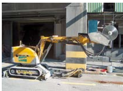
Alcan Wallis: Schneiden von Alu-Stromschienen mit Spezialanfertigung aus eigener Werkstatt
