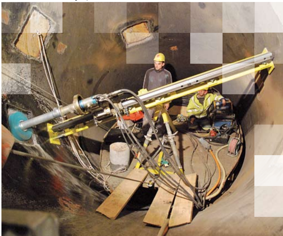
Puits blindés Biedron: carottages spéciaux dans des conditions difficiles
